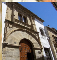
C.A. UNED Úbeda C/Gradas, 10
